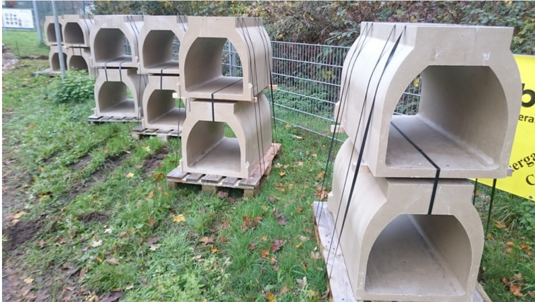
Bauteile für den Amphibientunnel Mühlengasse Höhe Gemeindeobstbongert Foto Rolf Brandt
