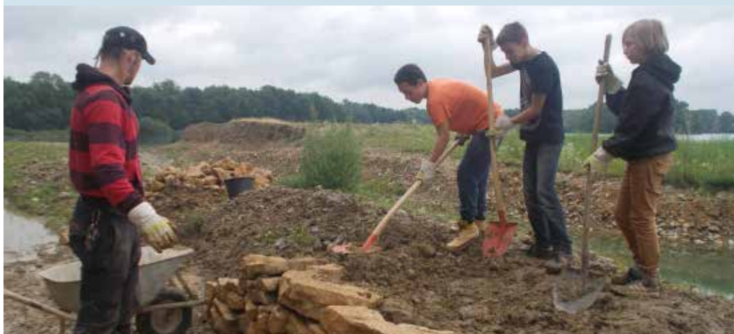
Schüler bauen Trockenmauern im Zuge der Renaturierung des Opfinger Baggersees. Fotos: Stiftung WaldHaus Freiburg (Diese Bilder können bei der Pressestelle der UN-Dekade in druckfähiger Auflösung angefordert werden.)
